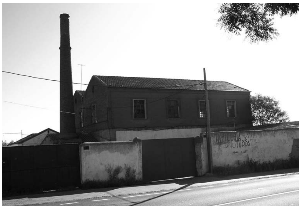
Figura 4. Primitiva casa de máquinas.
