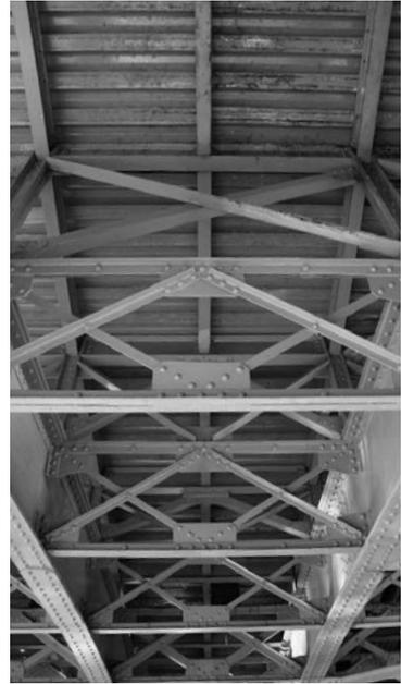
Fig. 11: Detalle de la estructura del puente de Enrique Estevan (montantes, viguetas, largueros y hierros zores)
