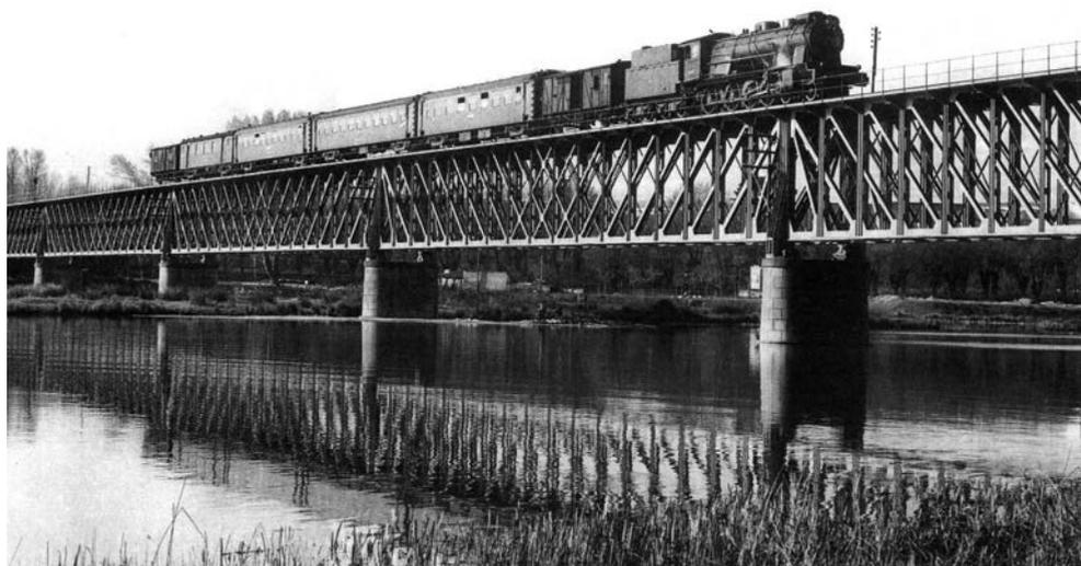
Fig. 3: El puente del Pradillo con la estructura metálica renovada en 1933 ([www.afzamorana.es](http://www.afzamorana.es))
