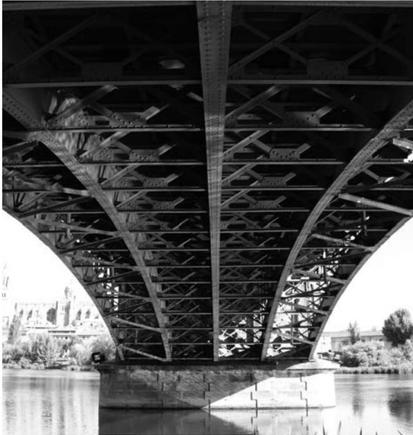
Fig. 10: Detalle de la estructura del puente de Enrique Estevan (arcos de los tramos metálicos)
